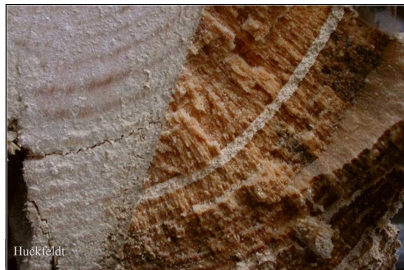
Abb. 9: Vom Echten Hausschwamm befallenes Holz: Es sieht im Sägeschnitt (links) oberflächlich gut aus; im Bruchbild zeigt sich die Holzzersetzung (stumpfer Bruch).
